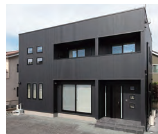
黒のガルバリウムと四角いデザインでシンプルモダン。室内とのギャップが面白い
